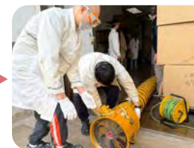
安裝風機補充循環新鮮空氣
