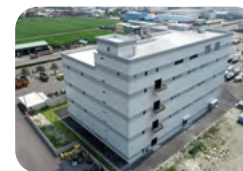
先進製造中心 II 中港半導體材料廠
