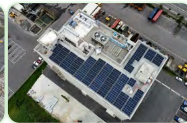
中港廠新建廠房 - 屋頂型太陽能發電系統
