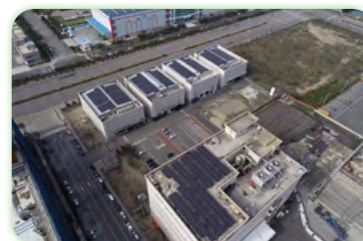
中港廠既有廠房 - 屋頂型太陽能發電系統
